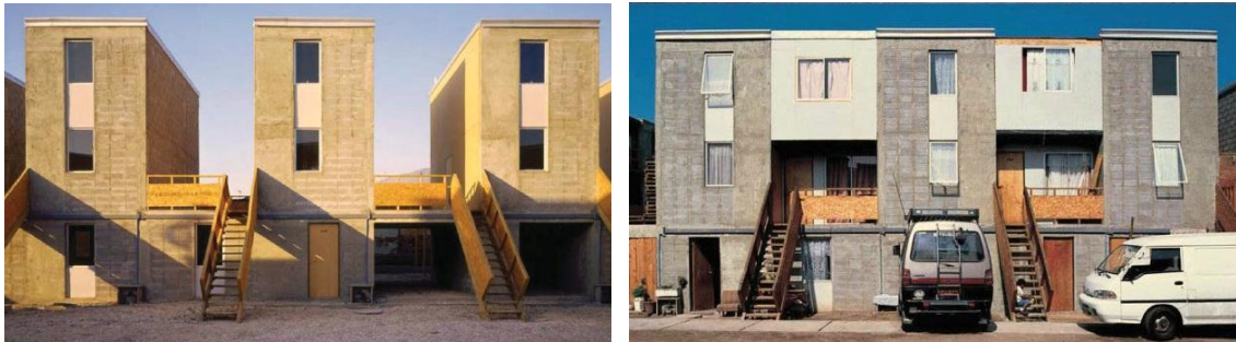
Fig. 22 - Quinta Monroy , ateliê Elemental, Iquique (Chile). Antes e depois da ocupação.
