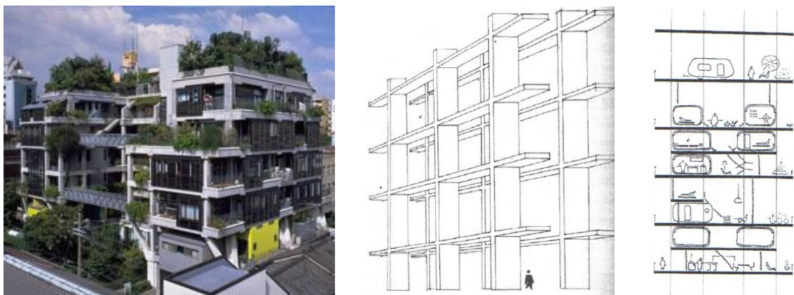
Fig. 61 - Next21 , Yositika Utida, Osaka (Japão). Foto, “suporte” e “preenchimento”.
