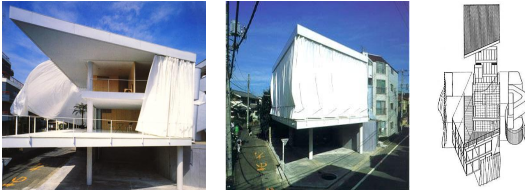
Fig. 34 - Curtain Wall House , Shigeru Ban, Tóquio (Japão).
