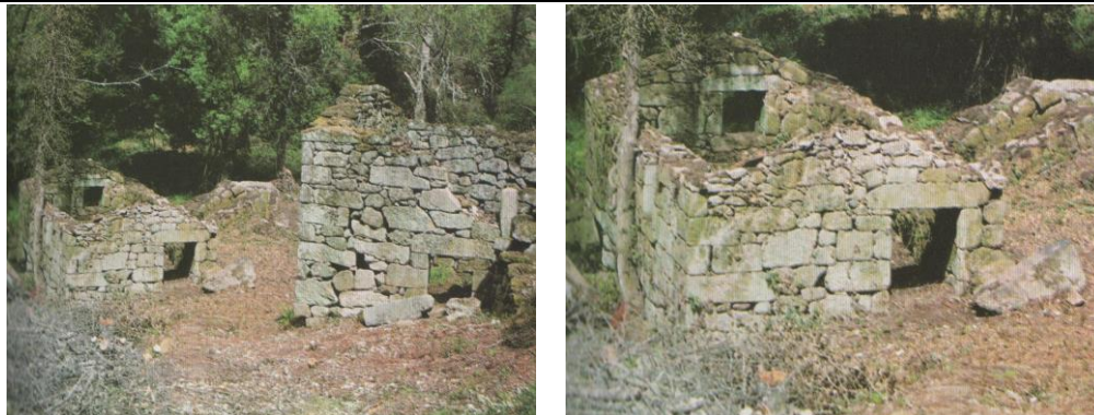
A casa de habitação (1ºplano, à direita) e o Moinho (2ºplano), visto de SE.
