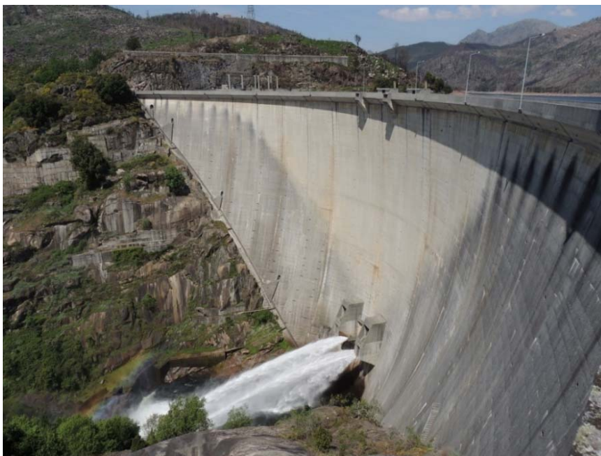
Figura 8 - Barragem Hidroelétrica Alto Lindoso, com detalhe da descarga do caudal ecológico.
