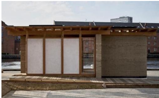
Fig. 45: Protótipo A Natural Pavilion, Dinamarca. Fonte – [internet] Disponível em: https://afasiaarchzine.com/2023/08/revaerk-arkitektur/
