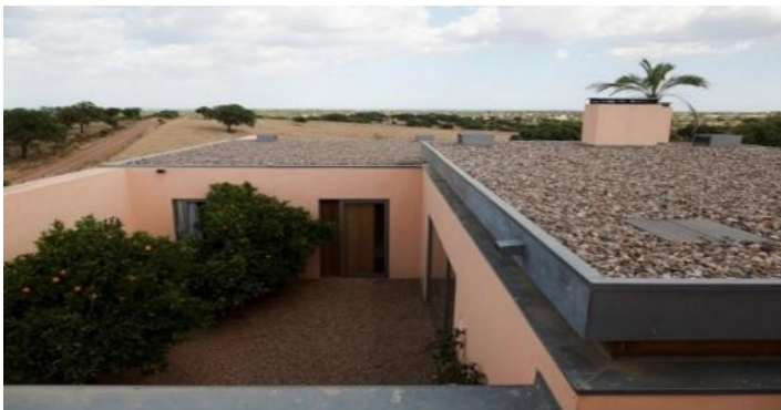
Fig. 26: Cobertura da Moradia Herdade Delgado, Beja. Fotografia de: Manuel Botelho. Fonte – [internet] Disponível em: https://commons.wikimedia.org/wiki/File:Bartolomeu_Costa_Cabral_Moradia_no_Alentejo_2_img_8960_1.jpg
