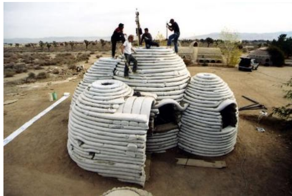
Fig. 11: Processo de construção de um abrigo a partir da técnica de superadobe no Irão. Fonte - [internet] Disponível em https://the.akdn/en/how-we-work/our-agencies/aga-khan-trust-culture/akaa/sandbag-shelters
