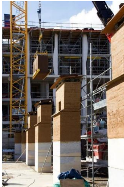
Fig. 39: Processo da montagem dos blocos pré-fabricados de taipa. Fonte – [internet] Disponível em: https://vergelyarchitectes.com/en/lyon-confluence
