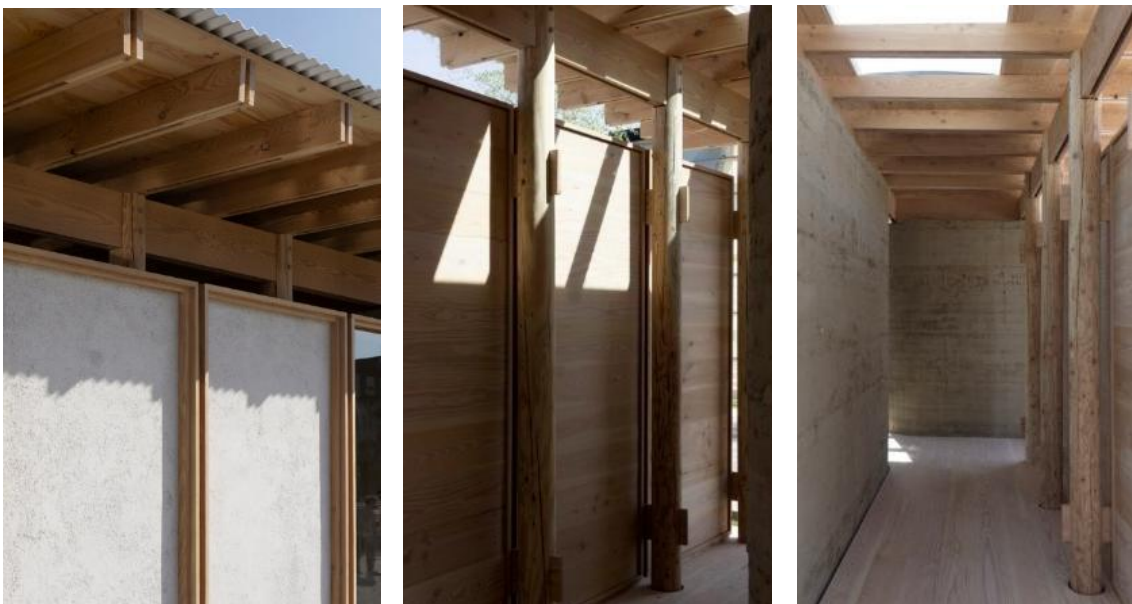
Fig. 46: Fotografias do protótipo. Relação madeira-taipa. Fonte – [internet] Disponível em: https://www.archdaily.com/1004372/a-natural-pavilion-revaerk/64b9ce22edf1692cd87f276e-a-natural-pavilion-revaerk-photo?next_project=no
