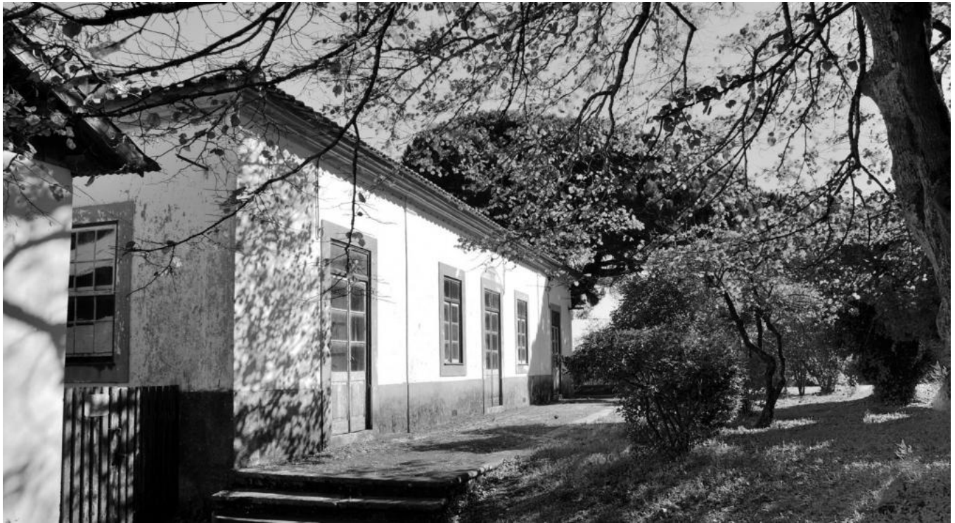
figura 29 – Antiga estação do Caminho de Ferro Americano em Pedreanes
