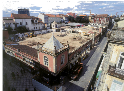
Figura 21 - Fotografia aquando a reconstrução do Mercado. (fotografia cedida em: fotografia: concurso Público de conceção para a Revitalização da Praça 2 de Maio em 2017-09-10).
