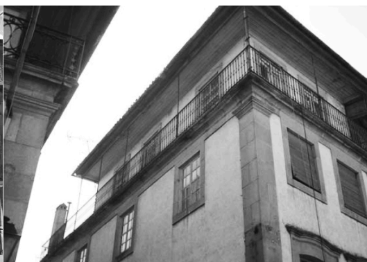
Figura 15 - Edifício onde é aparente Reabilitação e a construção de um novo piso -consultado em: Guia para a Reabilitação do Centro Histórico de Viseu em 2017-09-02)
