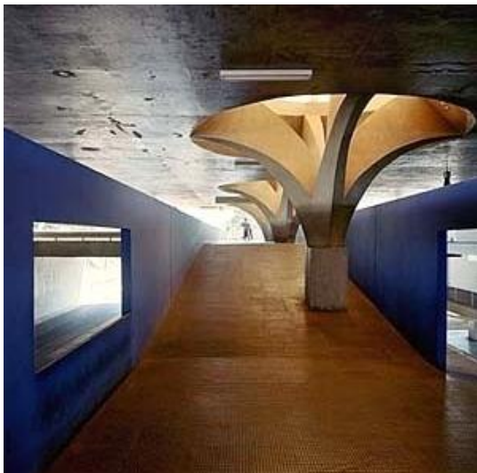
Fig. 19 Central de camionagem de São Paulo no Brasil (vista interior de um dos pilares)
