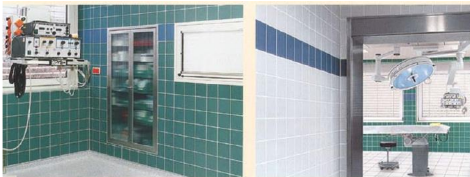
Fig. 91 e 92 interiores de um bloco operatório do hospital de Harzkliniken
