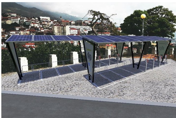
Figura 3.3 Posto de carregamento da Residência Universitária de Santo António.
