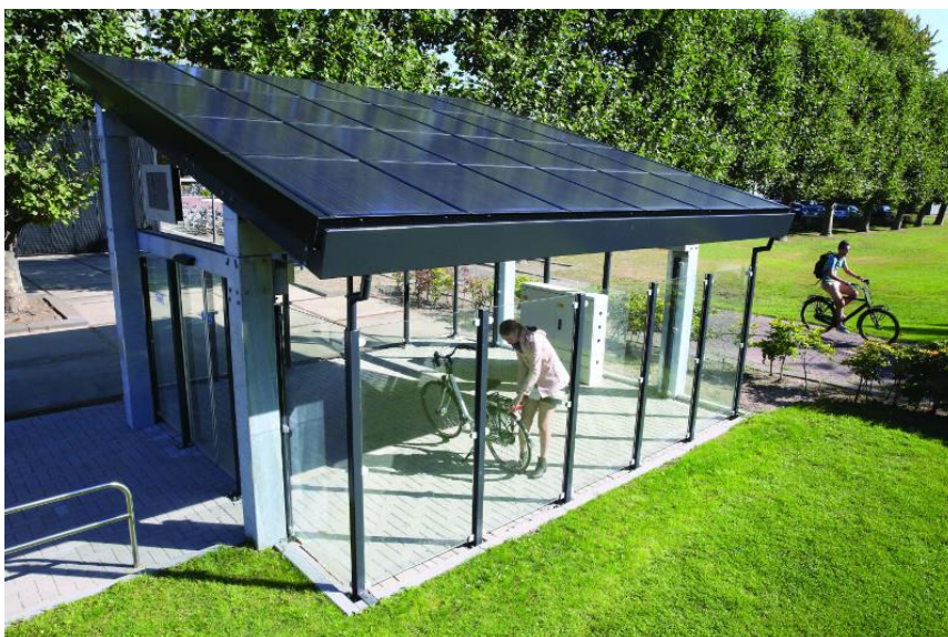
Figura 2.7 Estação de carregamento solar "SOLAR MOBILITY HUB"[11].
