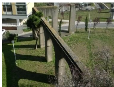
Figura 20 - Aqueduto da Quinta de São João da Penasqueira, Olivais Norte
