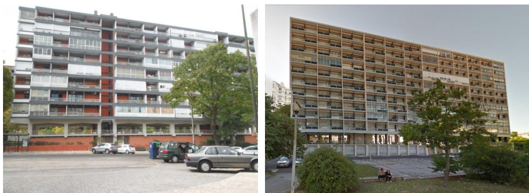
Figura 143 - Situações de descaraterização dos edifícios provocada pelas marquises
