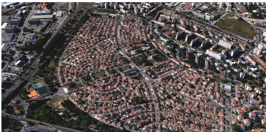
Figura 135 - Vista panorâmica Alameda da Encarnação e Parque Urbano dos Olivais
