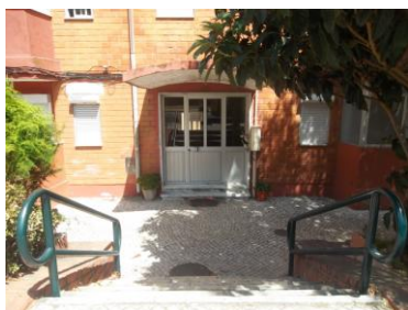
Figura 63 - Acesso por escadas, Olivais Norte
