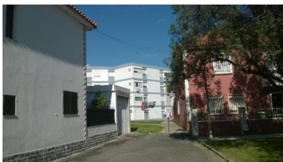
Figura 49 - Exemplo de acesso pedonal a partir da R. dos Lojistas, Olivais Norte
