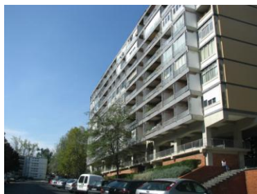
Figura 88 - Edifício betão à vista, Olivais Norte
