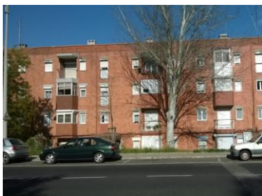
Figura 87 - Edifício com revestimento de tijolo, Olivais Norte
