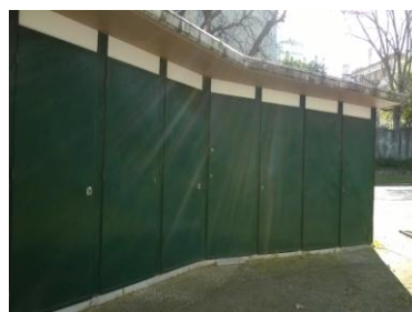
Figura 58 - Arrecadações nos blocos em banda da rua Alferes Barrilero Ruas, Olivais Norte
