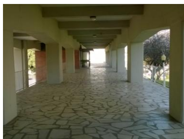
Figura 70 - Pilotis , bloco de Categoria III, Olivais Norte
