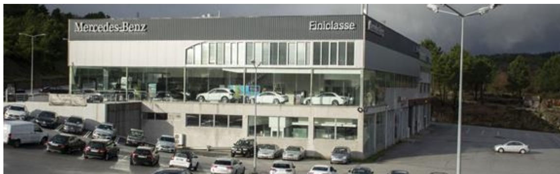
Figura 5 - Edifício Finiclasse na cidade da Guarda
