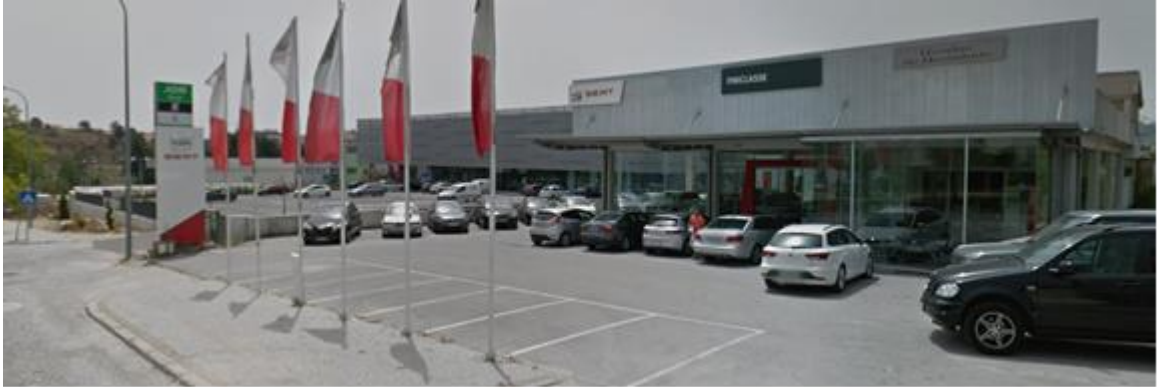
Figura 7 - Edifício Finiclasse representante da marca SEAT na cidade da Guarda
