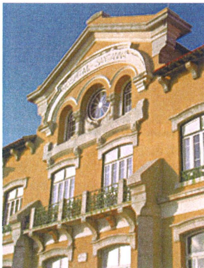
Fig. 20 – Sanatório da Parede (1902) – Arqº Rosendo Carvalheira
