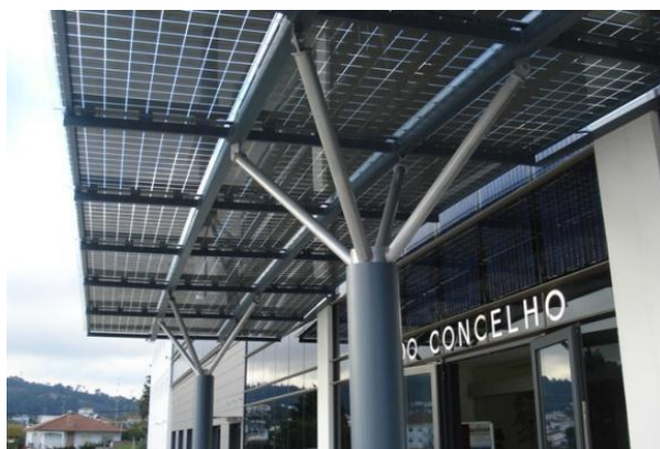
Figura 55 - Dispositivos fotovoltaicos de sombreamento.
