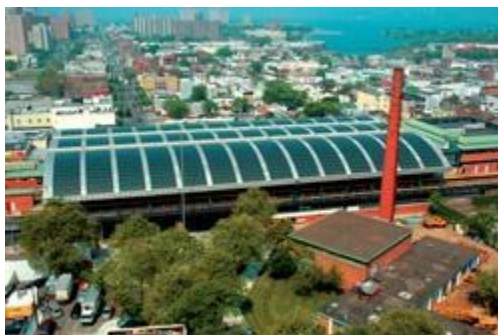
Figura 54 - Cobertura de vidro fotovoltaica.
