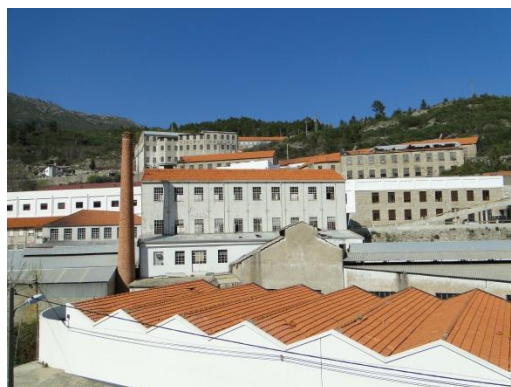
Figura 3.7 - Complexo industrial do Sineiro.
