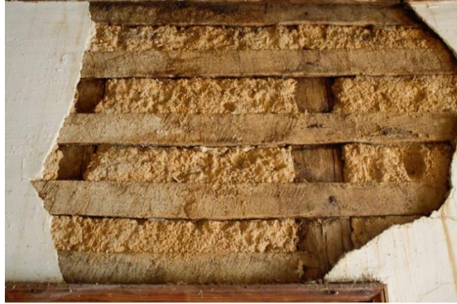
Figura 57- Interior de parede divisória
