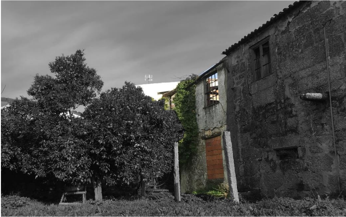
Figura 50- Ampliação do Edifício principal (zona em ruínas)
