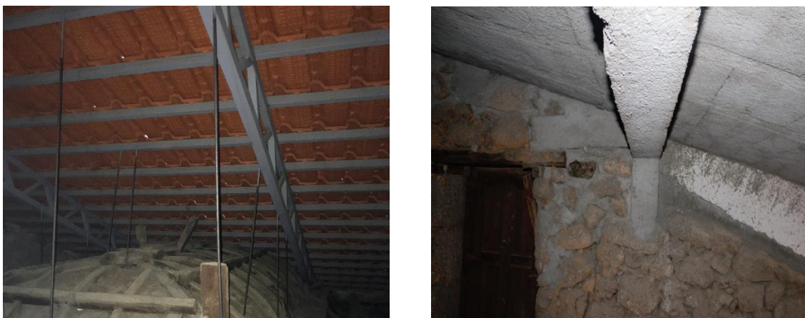
Figura 62 - Estruturas do telhado
