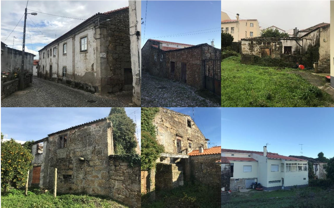
Figura 56 - Fotos do exterior dos edifícios
