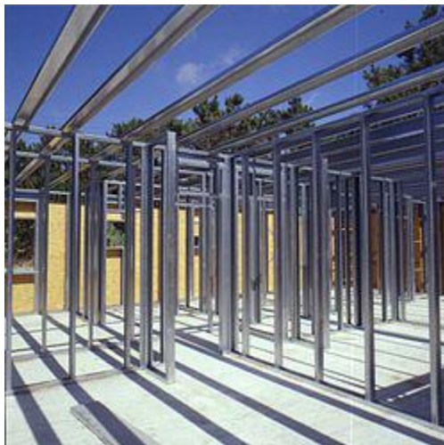
Figura 4.4: Exemplo de edifício construído com sistema estrutural em aço leve enformado a frio. (futureng, 2014)
