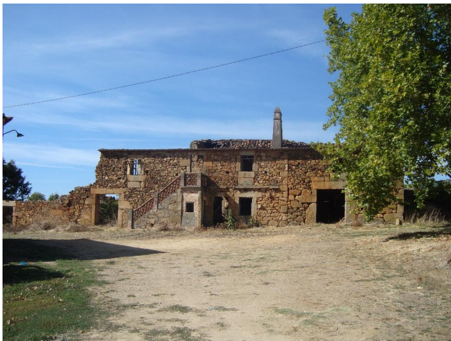
Ruínas do edifício principal
