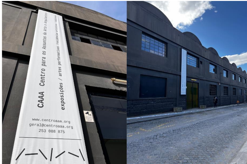
Figura 8 – Fachada do CAAA.
