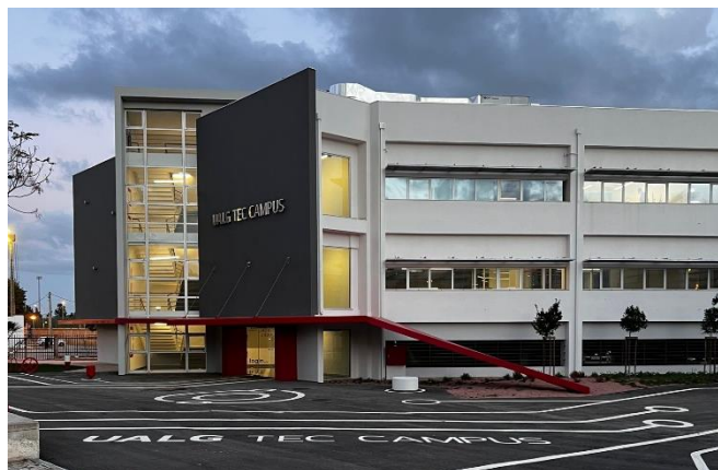
Figura 6 – Fachada do UALG Tech Campus, Campus da Penha na Universidade do Algarve.
