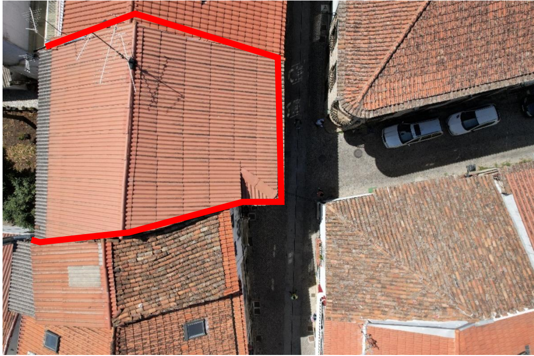
Figura 4. 66 - Imagem aérea do Edifício em estudo
