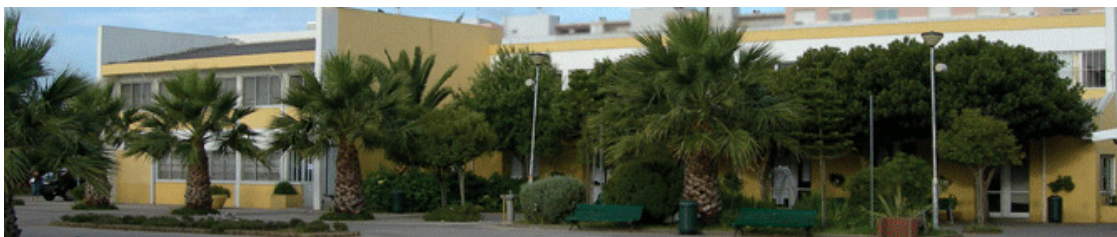
(Imagem 20) - Bloco A da Escola Secundária Luís de Freitas Branco
