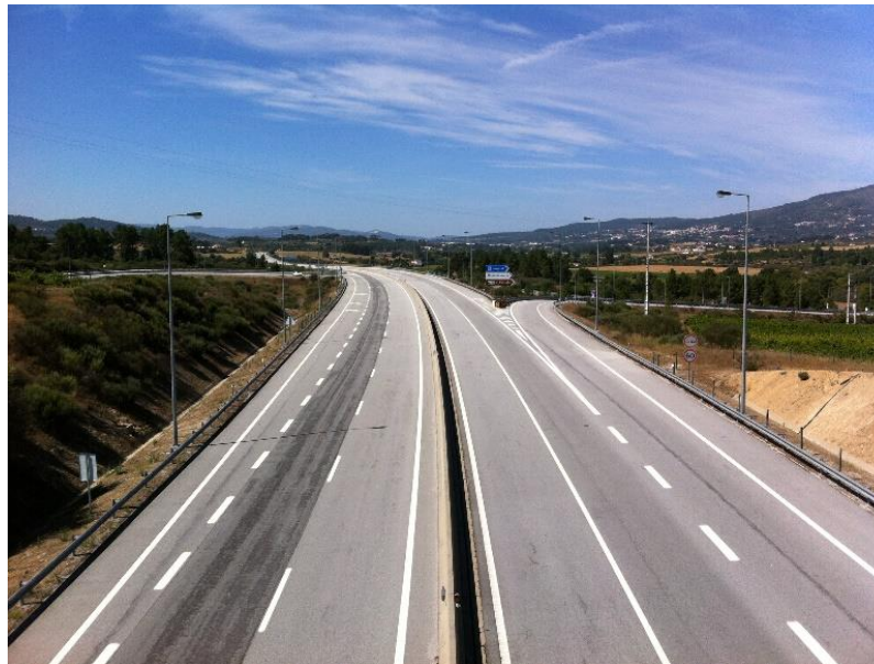
Figura 3.4 - Foto dos segmentos junto às rampas de aceleração e desaceleração tirada do viaduto a norte do nó 31, Covilhã Norte.
