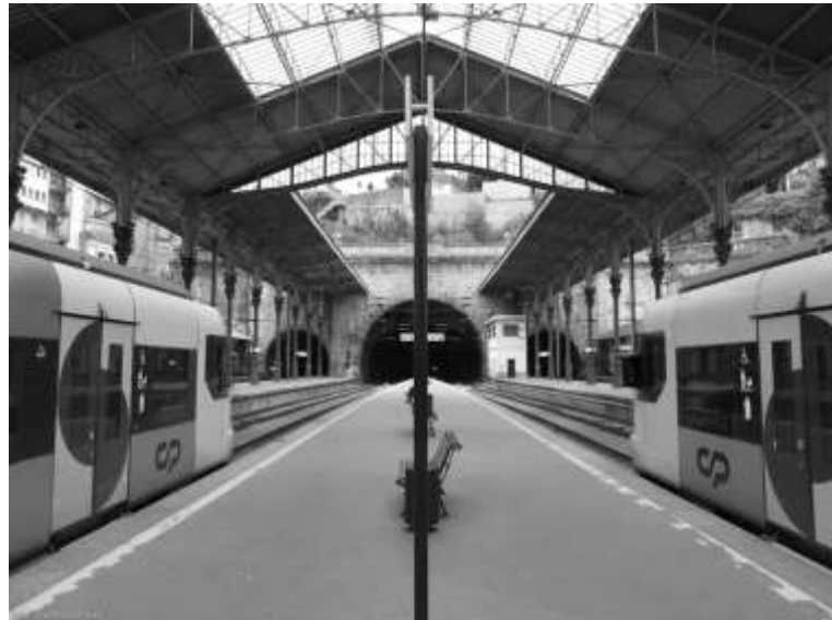
Figura 1.2.1- Imagem da estação de Caminho de Ferros de São Bento
