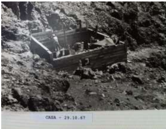
Figura 14- Casa em construção.
