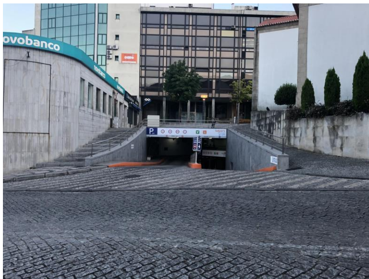
Figura 3.52. Principal entrada e a saída do silo auto da Praça do Município (Fonte: Autor).
