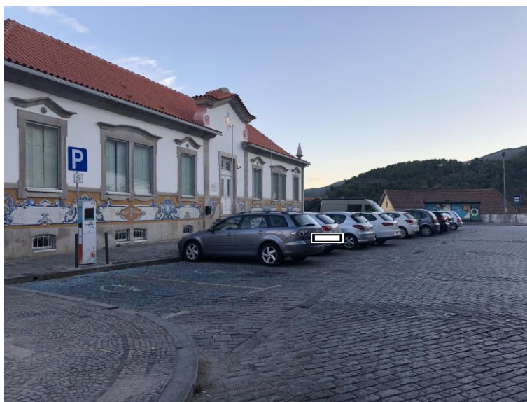
Figura 3.24. Largo com capacidade para o estacionamento de seis veículos normais e dois elétricos (Fonte: Autor).
