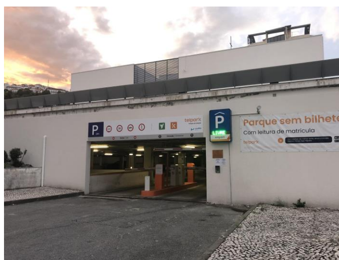
Figura 3.39. Silo auto da Estação, localizado na parte nova da Covilhã (Fonte: Autor).
