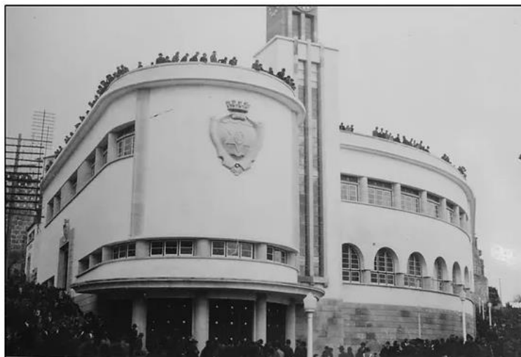
Figura 3.40. Edifício do Mercado Municipal nos anos 40 (Extraído de [52]).
