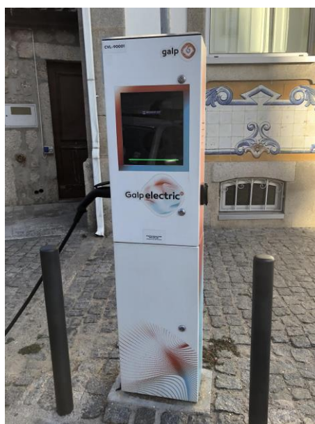
Figura 3.25. Posto de carregamento com capacidade para o abastecimento de dois veículos elétricos (Fonte: Autor).
