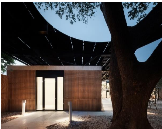
Figura 38: Vista interior da Embaixada.
