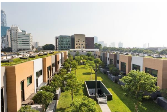
Figura 35: Vista das Residências do Corpo Diplomático.
