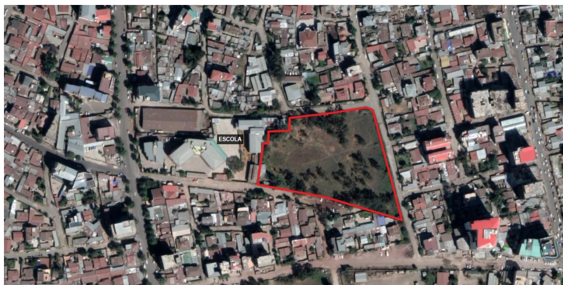
Figura 49: Vista Aérea do Local de Implantação.
