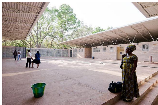
Figura 47: Pátio Central do Complexo Desportivo.
