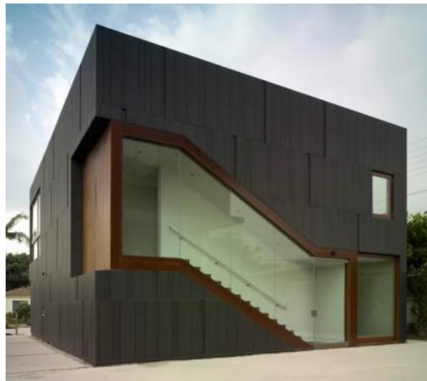
Figura 54. Mush House, Los Angeles Studio 0.10 Architects - Edificação revestida a zinco
