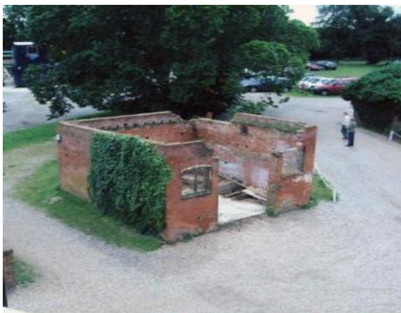
Figura 18 - Dovecote Studio - Ruína antes da intervenção
