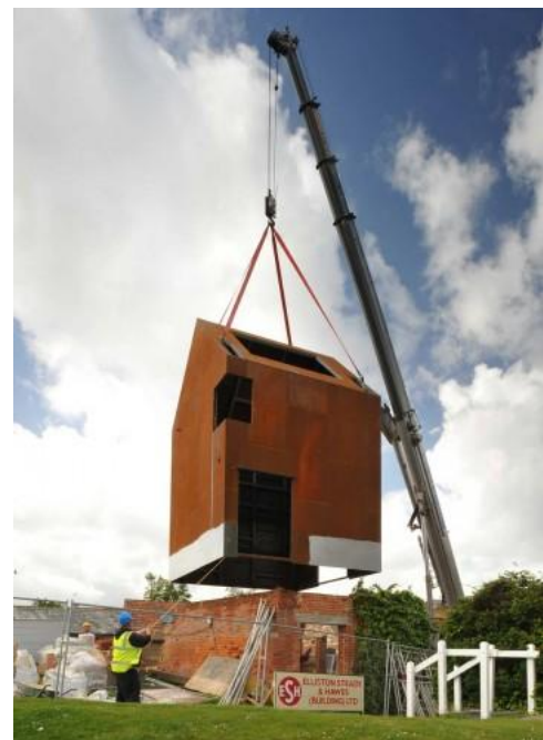
Figura 20 - Dovecote Studio - Fase de construção
