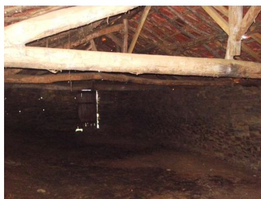
Figura 17. Estrutura do telhado em troncos
