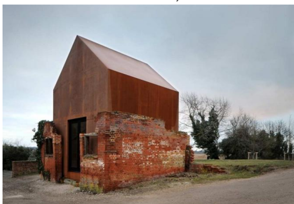
Figura 19 - Dovecote Studio - Ruína após a intervenção
