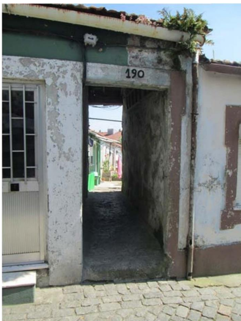
Figura 13: Entrada de uma ilha na zona das Antas, Porto. Fonte (Maçaira, 2015)
