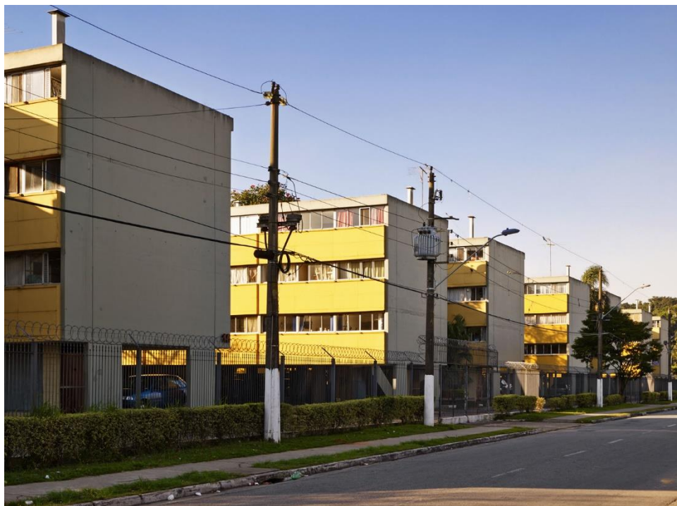
Figura 7: Conjunto Habitacional Zezinho Magalhães, Guarulhos. Fonte: ( https://www.nelsonkon.com.br/conjunto-habitacional-ccap/ )
