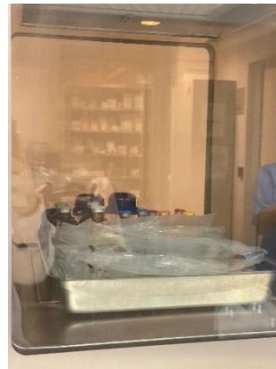
Figura 33: Transfer de conexão das duas salas
