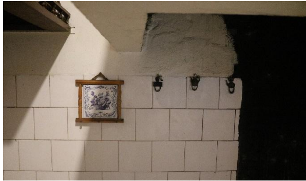
Fotografia do Forno a Lenha da Cozinha
