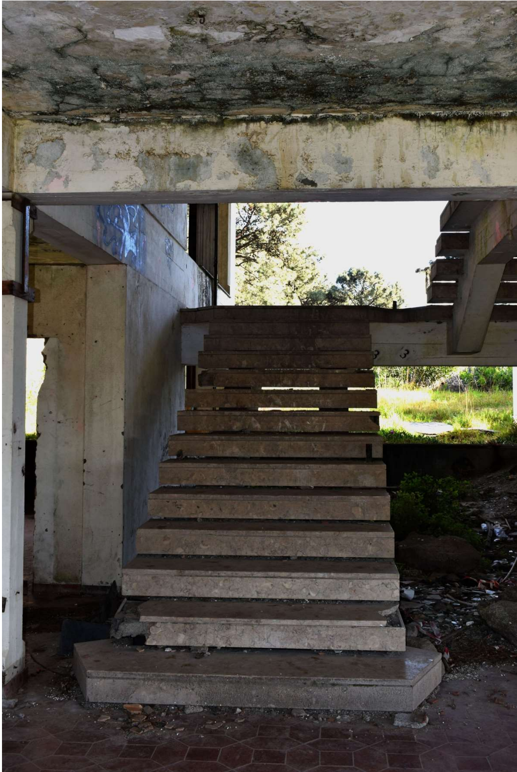
fig. 31 - Escadas existentes - volume Nascente
