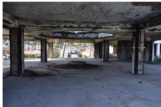
fig. 9 - estado atual LUZIAMAR - octógono piso 1
