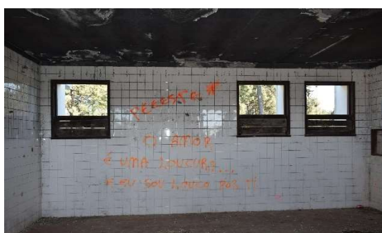
Figura 12 - vãos existentes (foto do autor)
