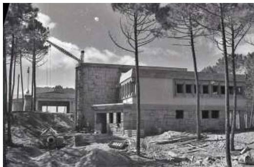
fig. 6 - Construção do LUZIAMAR (Autor: Manuel da Fonte)
