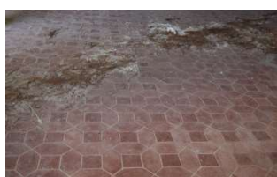
fig. 35 - pavimento original existente
