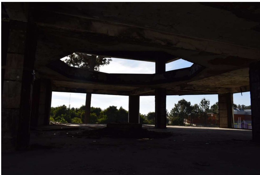
fig. 22 - piso 1, Octógono estrutura
