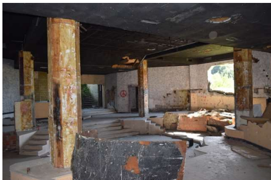
fig. 8 - estado atual LUZIAMAR - octógono piso 0
