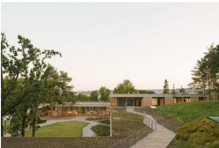
Figura 40- Relação do terreno com o edifício e materialidades (Ctyrsten, 2024)
