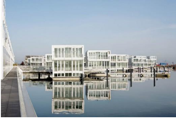
imagem 15_Casas flutuantes em ijborg
