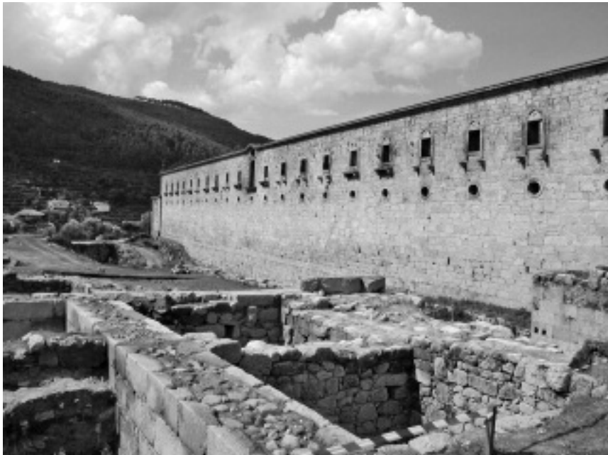
Fig.25 - Dormitórios do Mosteiro de S. João de Tarouca (séc. XVII) e zona da cozinha e claustro (séc. XII).
