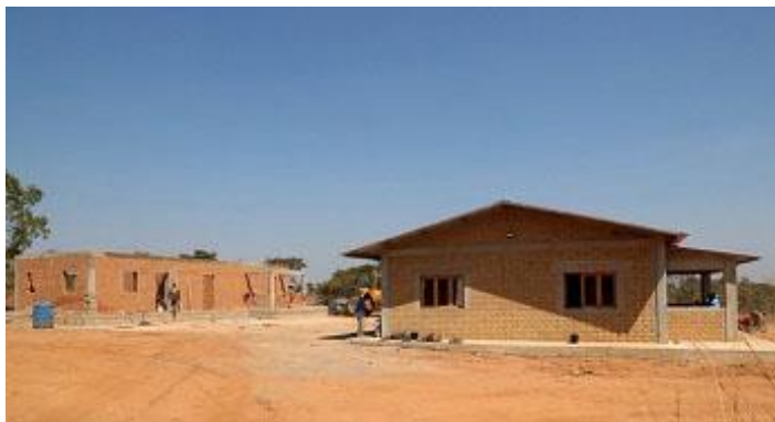
Figura 20 - Construção de casas em adobe, Angola
