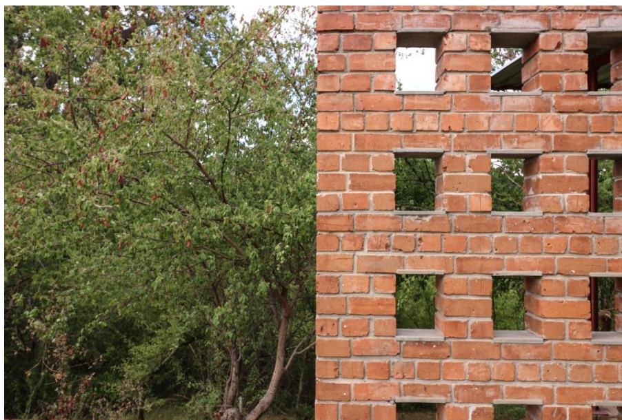
Figura 25 - Paredes em BTC, Benga Riverside Residential, Moçambique.
