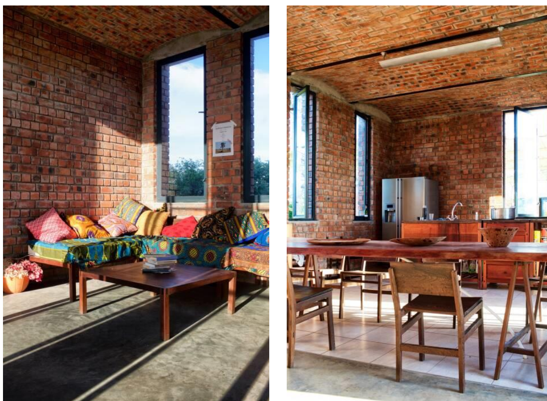
Figura 26 – Interior com paredes e teto em BTC, Benga Riverside Residential, Moçambique.
