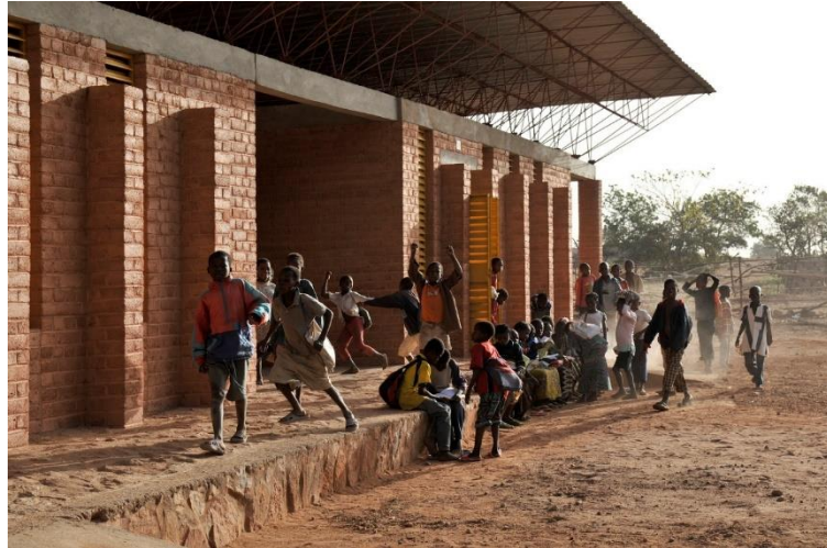
Figura 31 - Escola Primária de Gando
