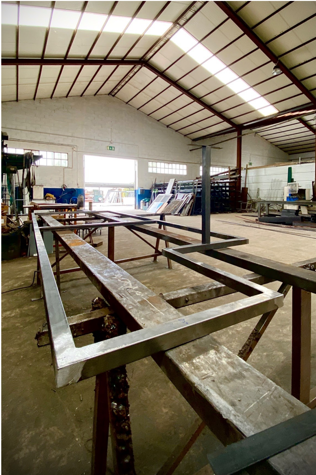
Figura 53 Produção da estrutura base (2)
