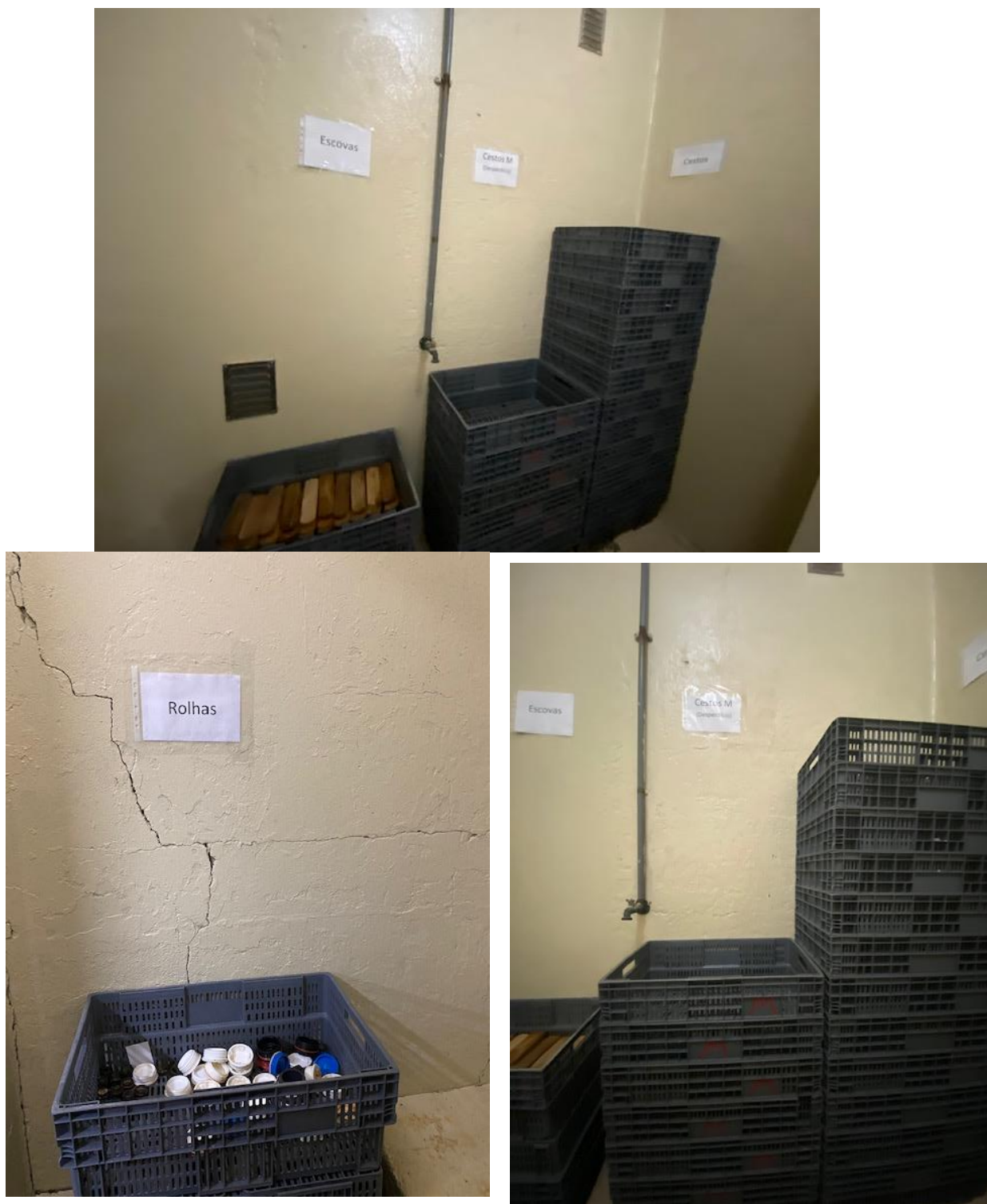
Figura 76 - Armazém de utensílios com placas sinaléticas indicativas do local correto de armazenamento
