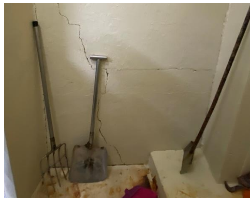
Figura 63 – Armazém de utensílios
