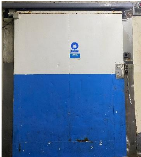
Figura 31 - Câmara de conservação n°1
