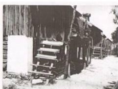
Fot. -> Escaroupim - aspecto da aldeia do lado de salvaterra. Nota que a casa do primeiro plano assenta sobre pilares de madeira, sendo a partir disso muito comum e de salutar as estacas de madeira.
