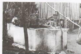
39. Caneiras — o furo. Reparar no contraste entre a construção tosca das casas (que se adaptam ao furo) e a sólida construção de alvenaria do furo — símbolo de progresso dum povo avieiro. (Salvado, 1959)
