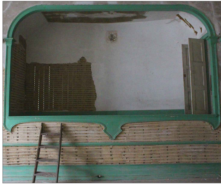
Imagem 246 - Levantamento fotográfico do Arco V8
