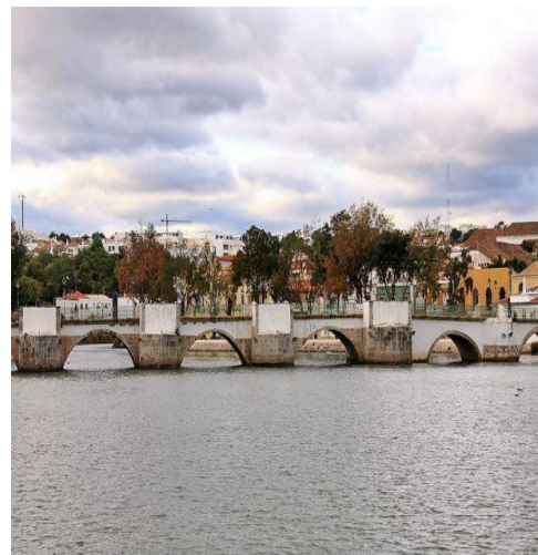
FIGURA 14. PONTE ROMANA SOBRE RIO GILÃO
