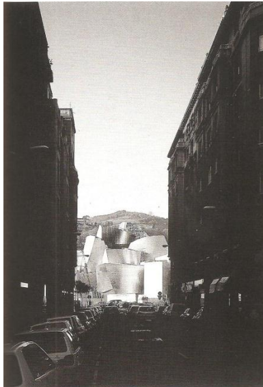
Fig. 67 – Registo Fotográfico, Frank O. Gehry & Associates, Museo Guggenheim Bilbao, Bilbao, Espanha, 1991-1997
