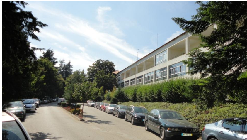
Figura 2 - Perspectiva do sanatório. Fonte: Fotografia nossa.
