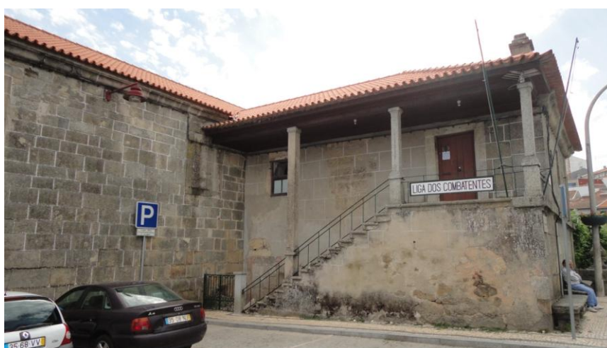
Figura 20 - Instalações da Liga dos Combatentes. Fonte: Fotografia nossa.
