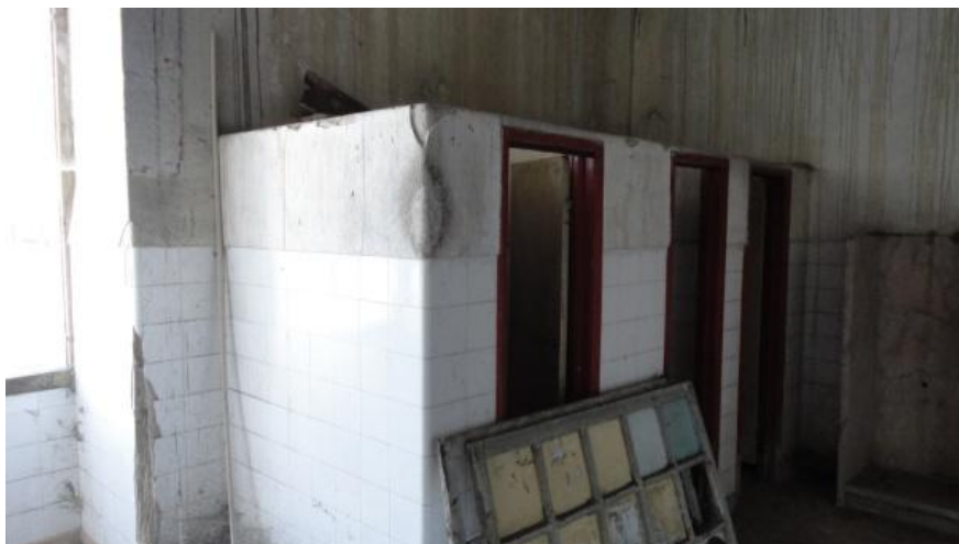
Figura 39 - Divisórias dos sanitários. Fonte: Fotografia nossa.
