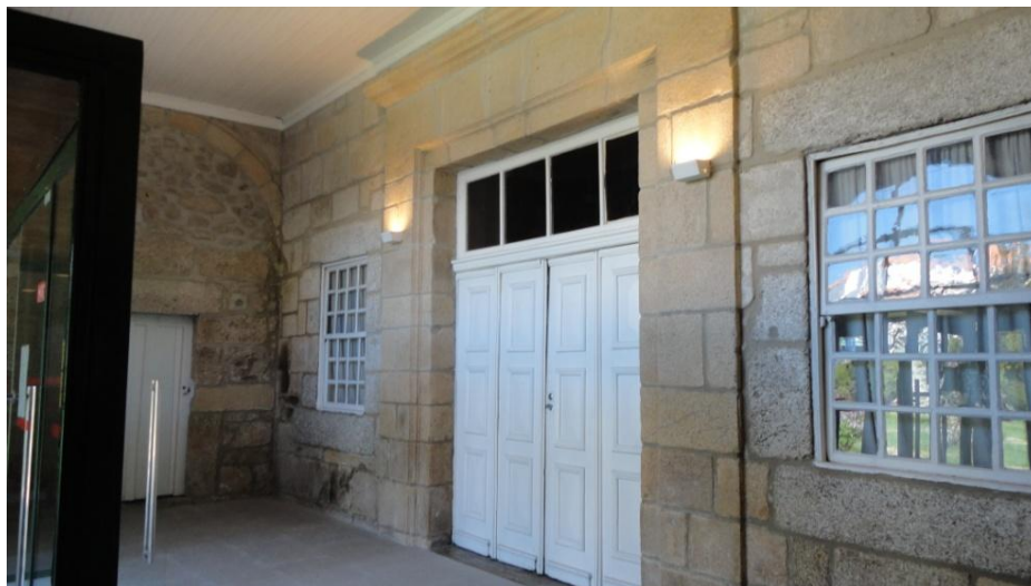
Figura 43 - Vista interior da entrada principal. Fonte: Fotografia nossa.
