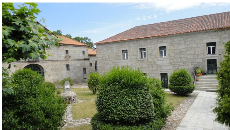
Figura 21 - Instalações do ADGRD e Direcção de Finanças. Fonte: Fotografia nossa.
