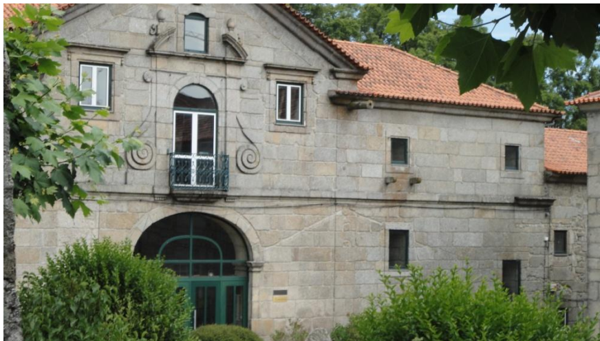
Figura 17 - Edifício do ADGRD. Fonte: Fotografia nossa.
