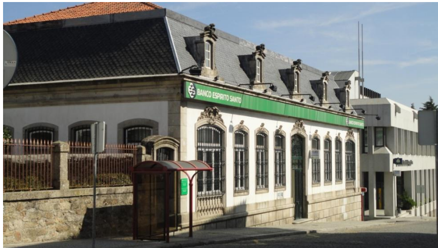
Figura 4 - Edifício do antigo Banco de Portugal. Fonte: Fotografia nossa.
