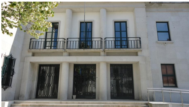
Figura 15 - Edifício do Tribunal. Fonte: Fotografia nossa.
