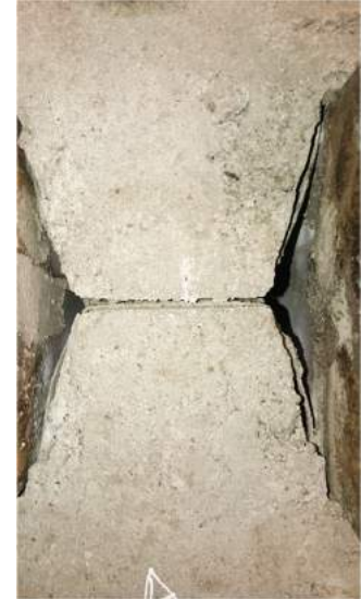
Figura 103 - Vista superior - CP.3.NSP após rotura
