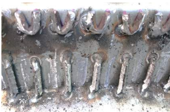
Figura 82 - Rebarbagem de varões
