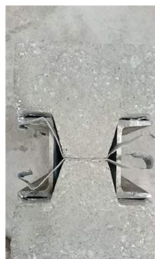
Figura 88 - Remoção de chapa de cofragem
