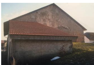
Figuras 19- Edifício existente
