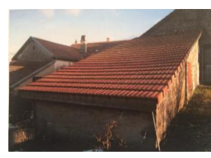
Figuras 24- Edifício existente
