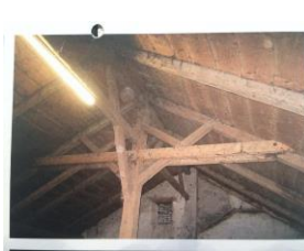
Figuras 23- Edifício existente
