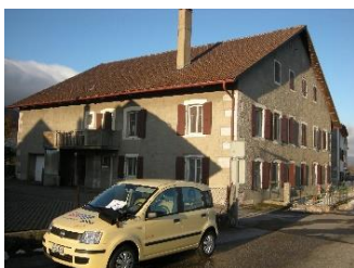
Figuras 16- Edifício existente
