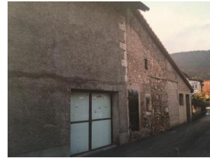
Figuras 21- Edifício existente
