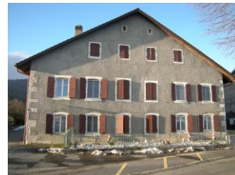
Figuras 18- Edifício existente
