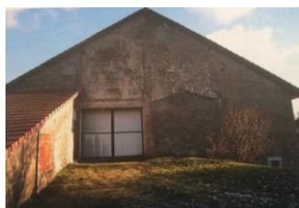
Figuras 22- Edifício existente
