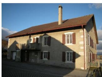
Figuras 17- Edifício existente
