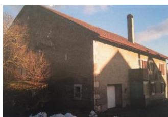
Figuras 20- Edifício existente
