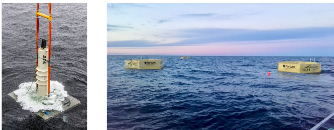
Figura 2.15: Gerador linear do dispositivo SEABASED durante a sua instalação no parque de energia das ondas de Sotenäs (esquerda) e respectivas bóias na superfície do mar (direita).
