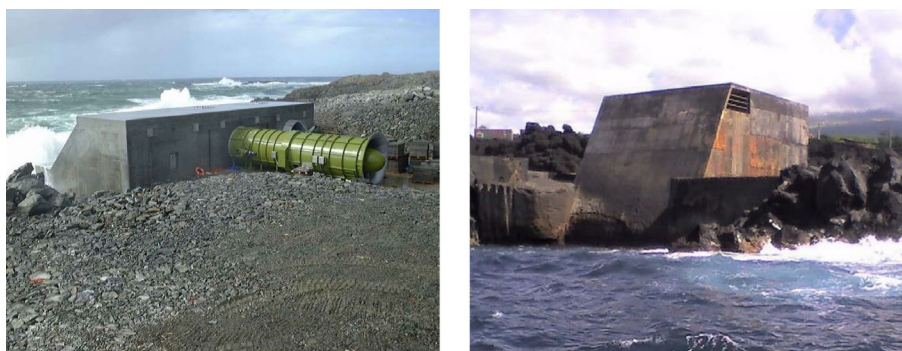
Figura 2.7: Central OWC LIMPET da Ilha de Islay, na Escócia (esquerda); Central OWC da Ilha do Pico, nos Açores (direita).
