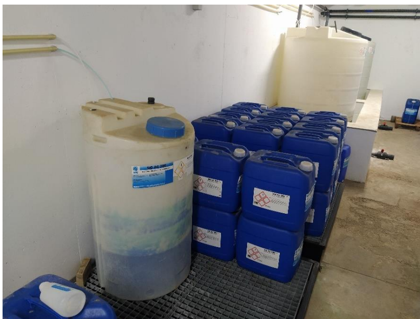
Figura 3.6 - Depósitos de armazenamento de reagentes desinfetantes
