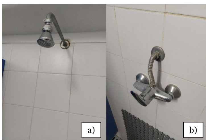
Figura 3.9 - a) Chuveiro de cabeça móvel; b) Torneira misturadora monocomando
