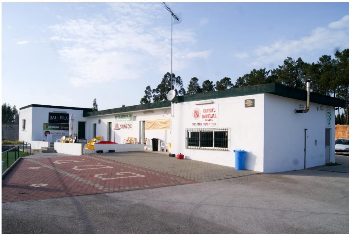
Figura 37 - Antigos balneários e bar do Campo Dinis dos Pinheiros. Fonte: Fotografia do autor.
