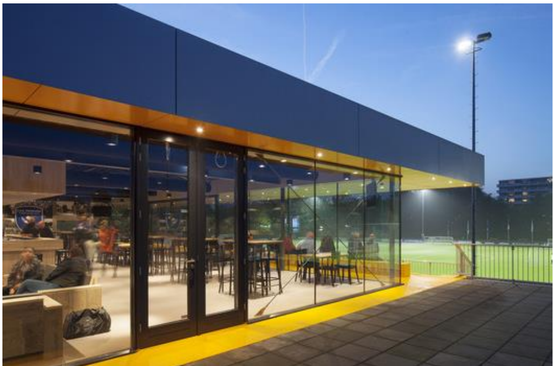
Figura 28 - Piso superior da instalação. Fonte: Archdaily
