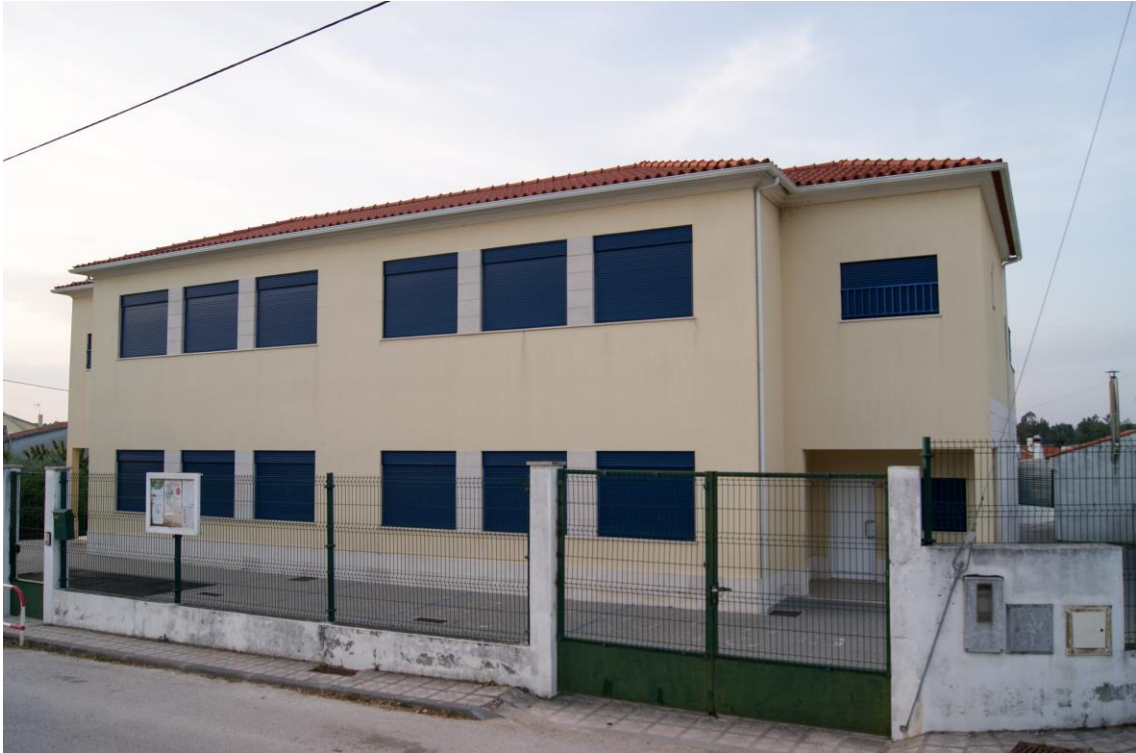
Figura 11 - Escola Básica da Machada. Fonte: Fotografia do autor.
