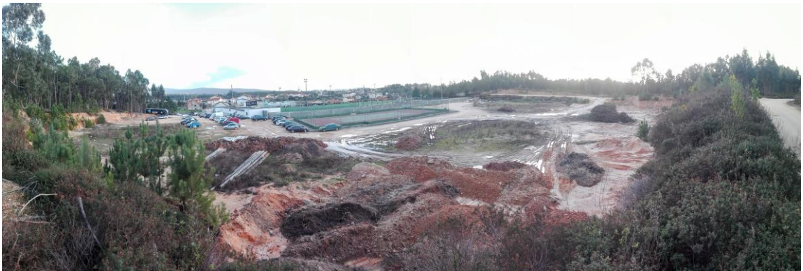
Figura 29 - Fotografia panorâmica da área de intervenção. Fonte: Fotografia do autor.
