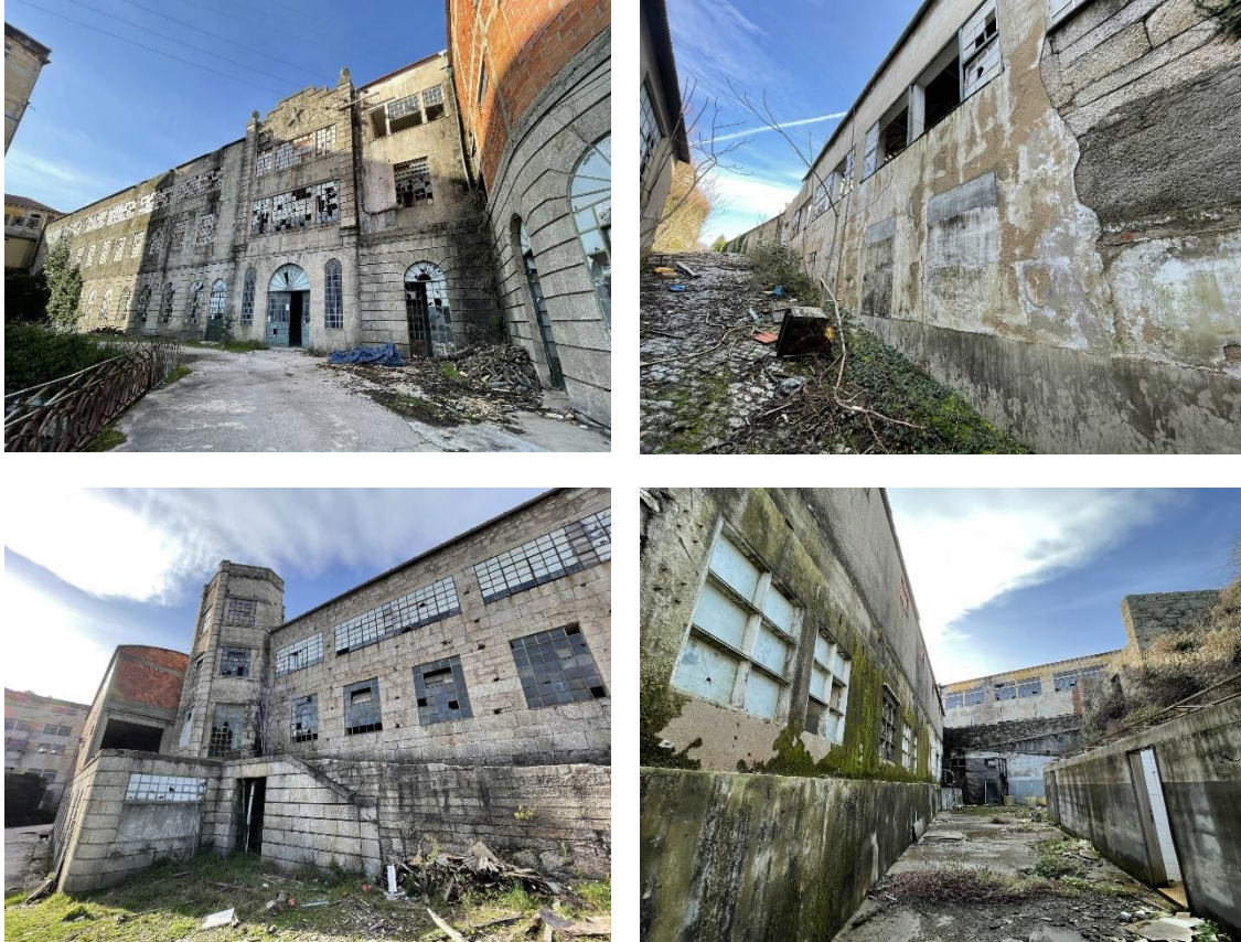
Figura 35 - Fachadas do edifício. Fotografias da autora, 2021.
