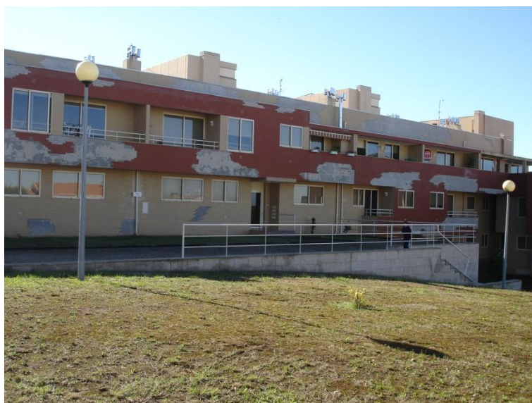
Figura 51 – Edifícios de habitação colectiva (n.ºs 1, 2, 3, 4, 5) - (Fonte: 62)
