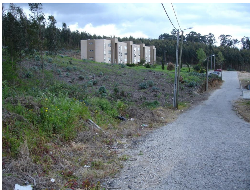
Figura 39 – espaços exteriores urbanos danificados (Fonte:49)
