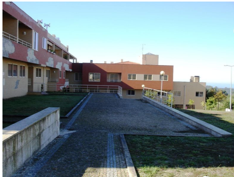
Figura 36 – Edifícios de habitação colectiva (Fonte:46)
