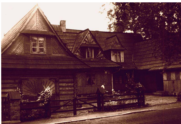
Figura 4.1 - Habitação de madeira em Zakopane.
