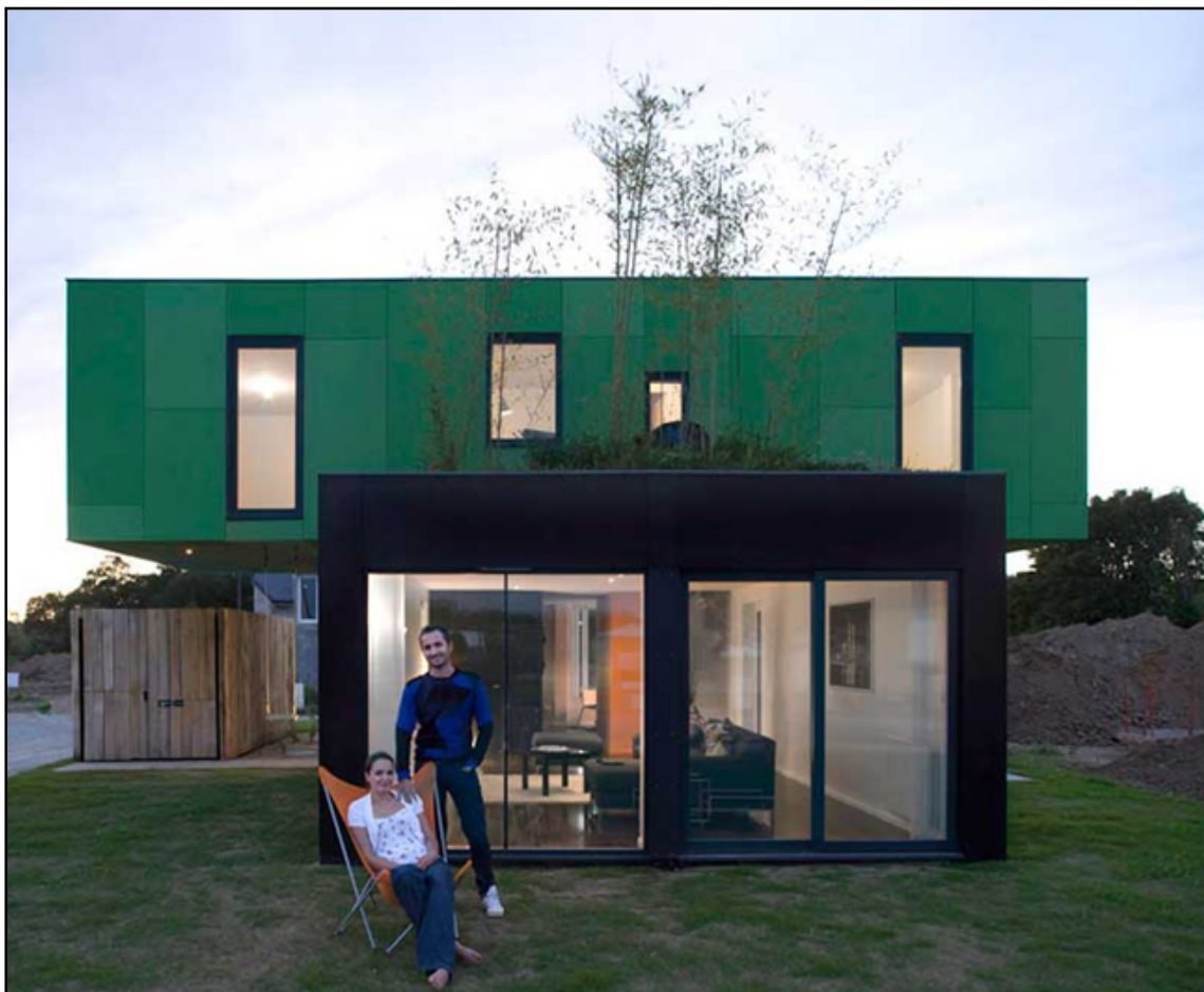
Figura 2.6 - Moradia unifamiliar, em França [20]
