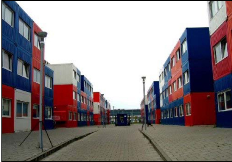
Figura 2.5 - Edifícios de residências universitárias, na Holanda [19]
