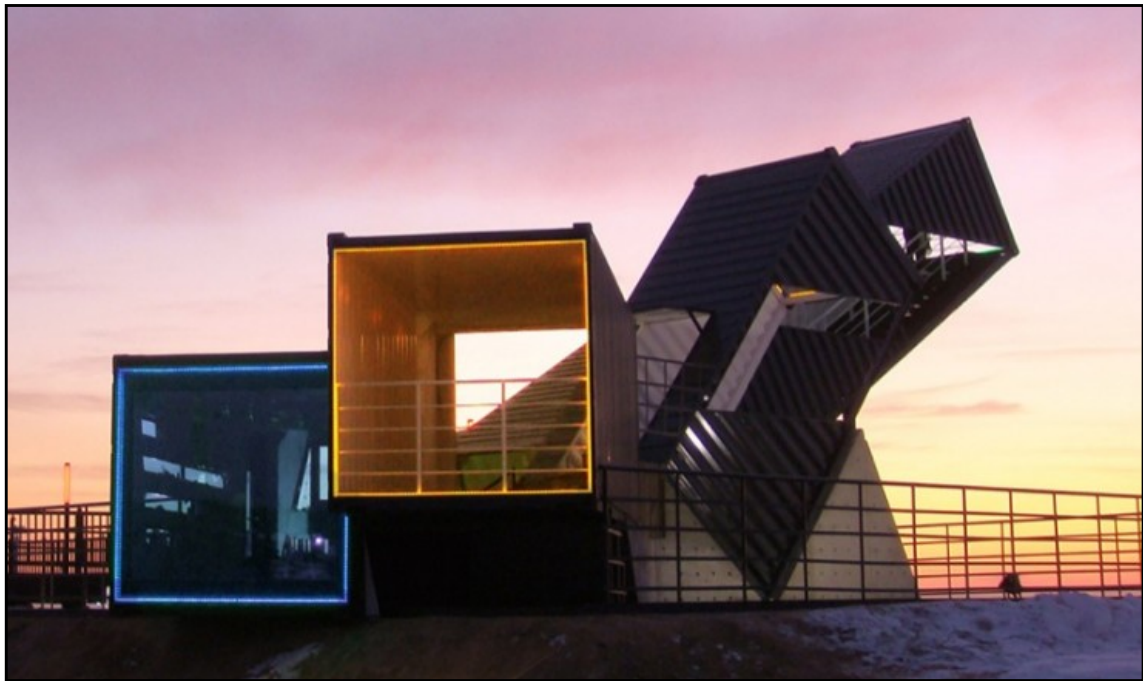
Figura 2.7 - Edifício público, “OceanScope”, na Coreia do Sul [21]
