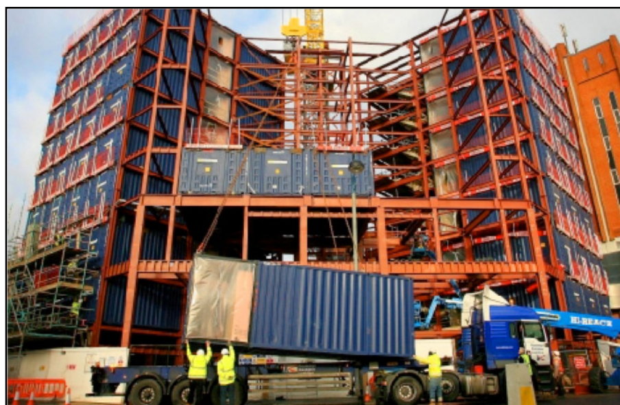
Figura 2.4 - Edifício para hotel, em Inglaterra (fase de execução) [18]
