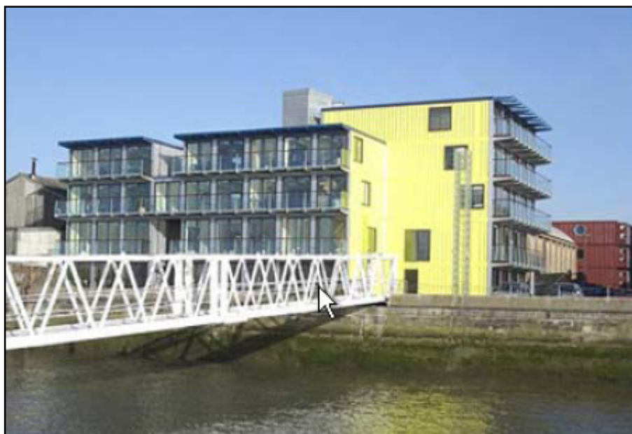
Figura 2.3 - Edifício de escritórios, em Londres [17]
