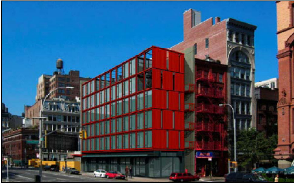
Figura 2.9 - Edifício de comércio e escritórios, em Nova Iorque [11]
