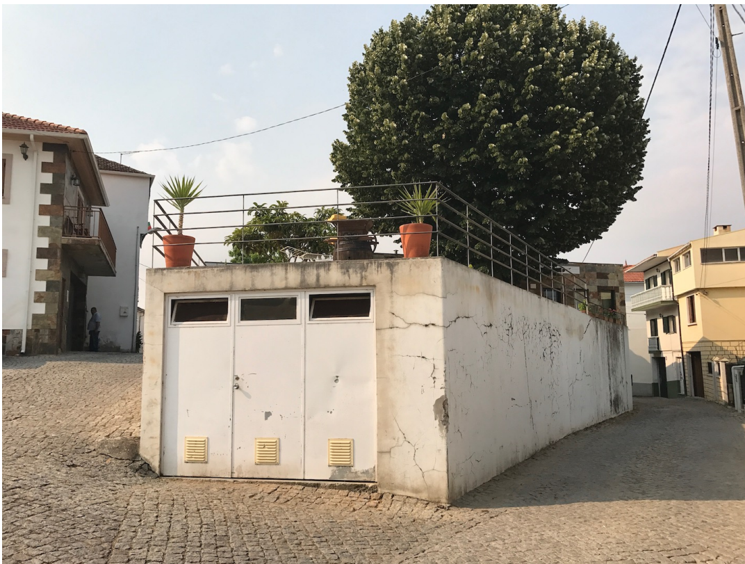
Anexo 3. Foto (02) do edifício existente e envolvente (fotografia tirada pelo autor)
