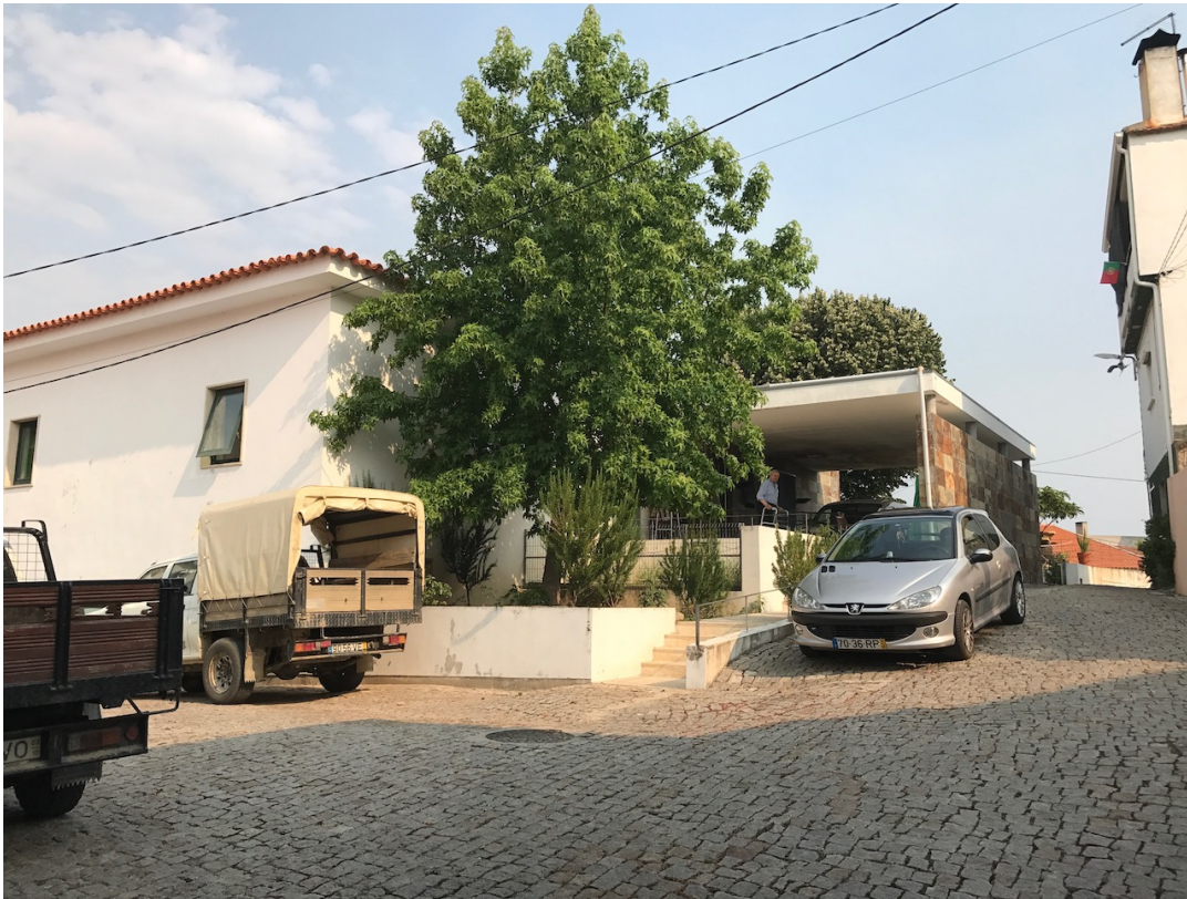
Anexo 8. Foto (07) do edifício existente e envolvente (fotografia tirada pelo autor)
