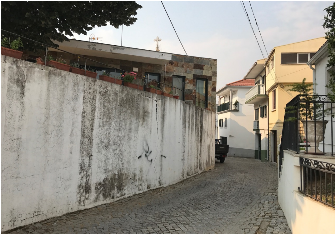
Anexo 4. Foto (03) do edifício existente e envolvente (fotografia tirada pelo autor)
