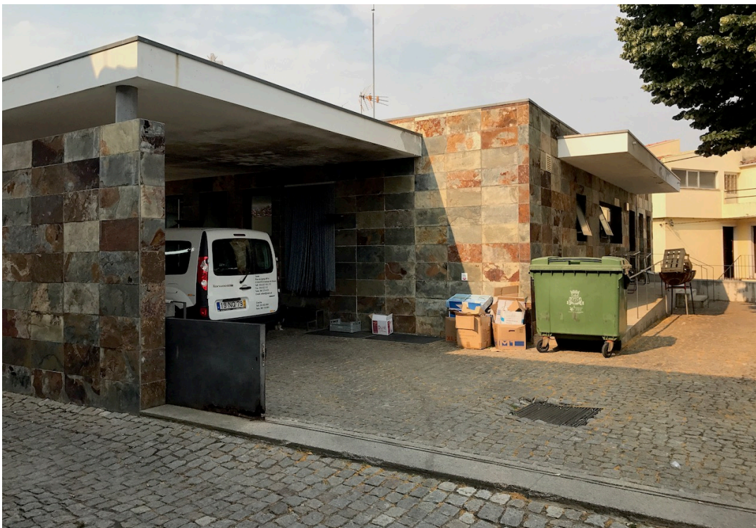
Anexo 9. Foto (08) do edifício existente e envolvente (fotografia tirada pelo autor)
