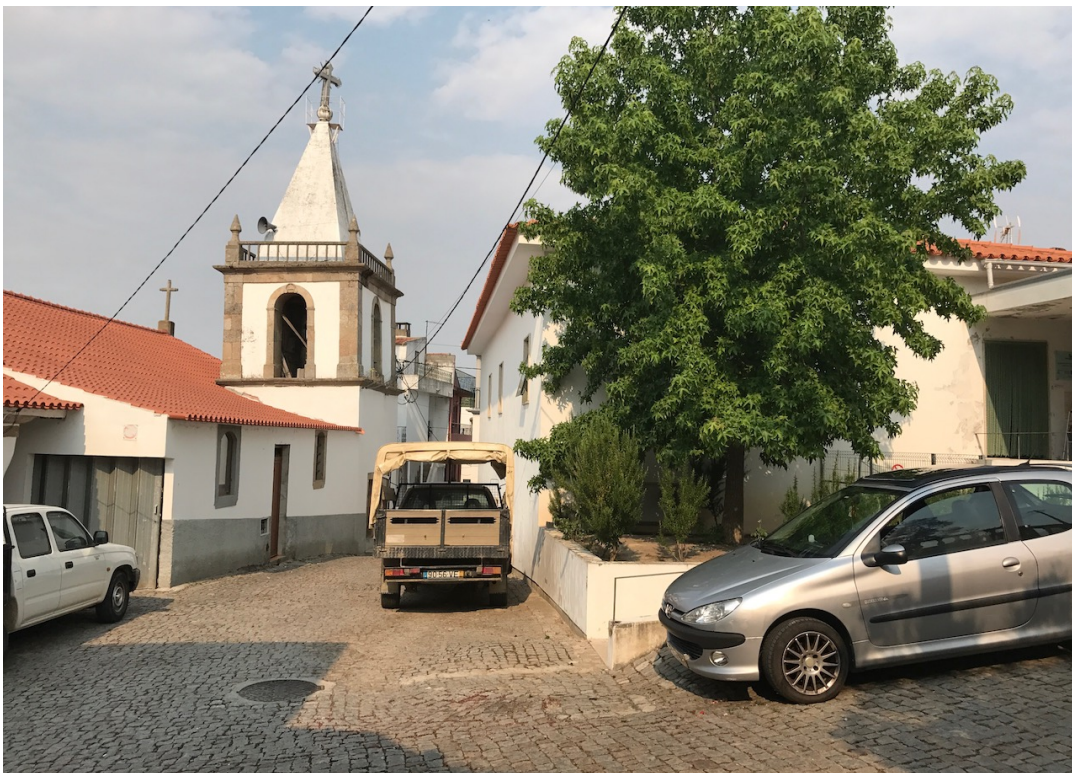
Anexo 7. Foto (06) do edifício existente e envolvente (fotografia tirada pelo autor)
