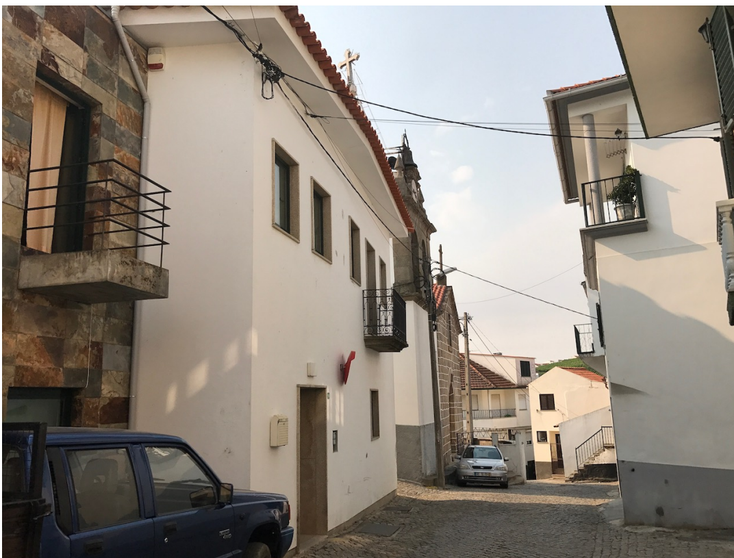
Anexo 5. Foto (4) do edifício existente e envolvente (fotografia tirada pelo autor)
