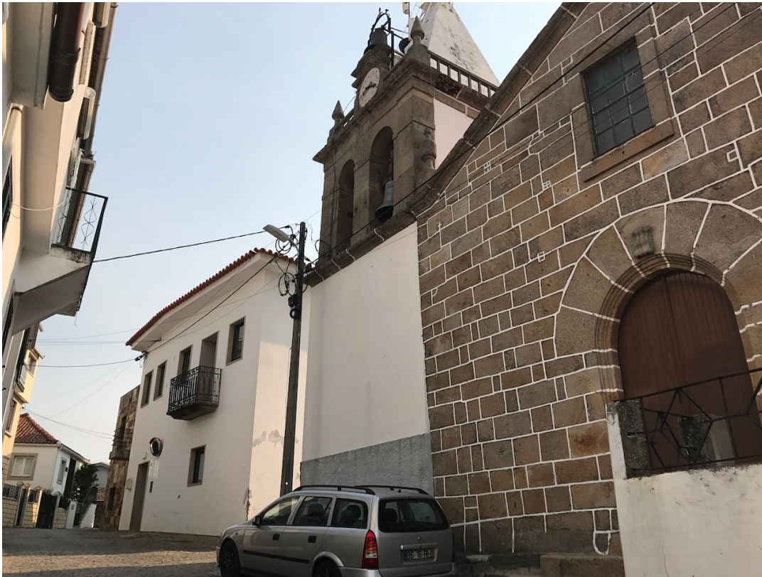
Anexo 6. Foto (05) do edifício existente e envolvente (fotografia tirada pelo autor)
