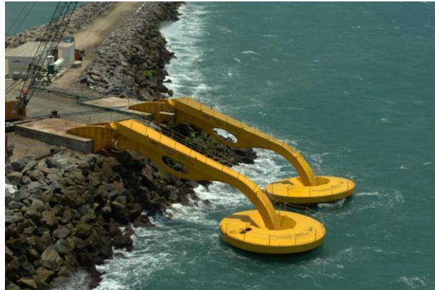
Figura 2.33: Protótipo de uma Central Hyperbaric Coppe no quebra-mar de São Gonçalo de Amarante, no Ceará [55-A].
