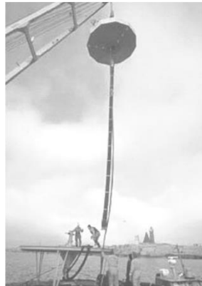
Figura 2.35: Montagem no local do Swedish Hose-pump [2.4].
